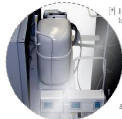
[\*] Il TAC consiste in uno smalto di protezione applicato su tutte le superfici dei componenti del circuito refrigerante a contatto con l'aria ambiente. Il trattamento, abbinato alle caratteristiche costruttive del modulo di essiccazione ALU-DRY, rende l'essiccatore FCT idoneo ad operare in condizioni di installazione sfavorevoli.
